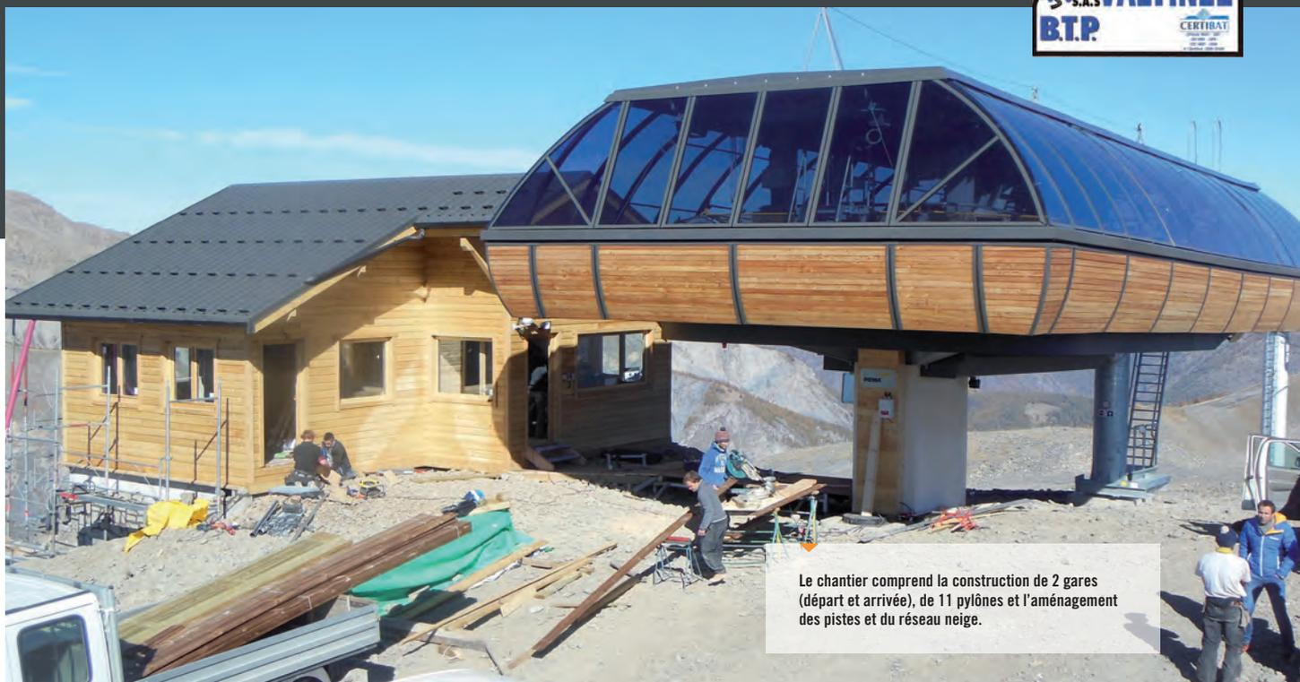
Le chantier comprend la construction de 2 gares (départ et arrivée), de 11 pylônes et l'aménagement des pistes et du réseau neige.
