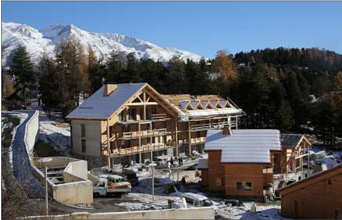
On s'active sur les chantiers d'altitude avant la période froide, comme ici à Auron, où plusieurs programmes sont en finition.
