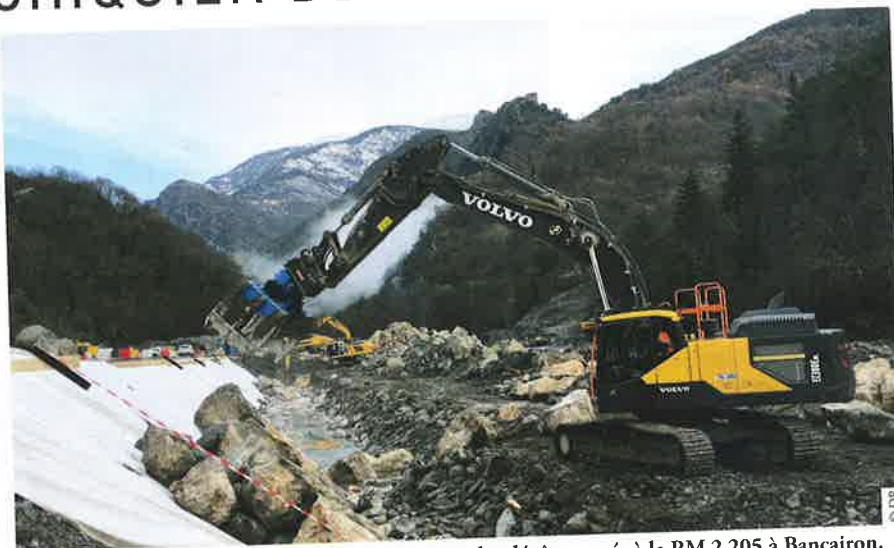
L'entreprise Valtinée à l'ouvrage sur la réparation des dégâts causés à la RM 2 205 à Bancairon.
